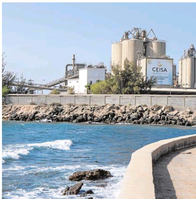
Imagen de la planta de Ceisa en Arguineguín. c7
